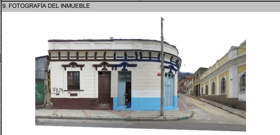
Fuente: Equipo Fotografía PEMP Patrimonio Inmueble
